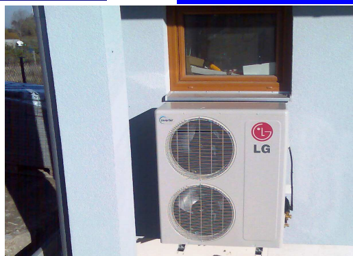
Příklad instalace TnG Air C1200i
